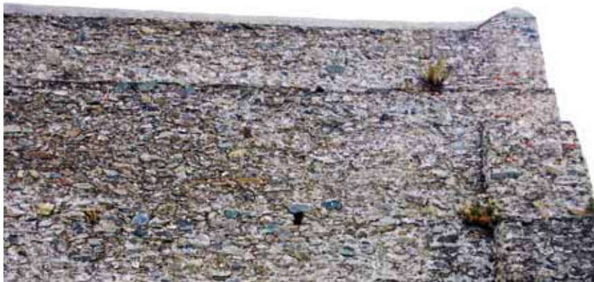
The impressive stone wall of Caz del Molino de Sedella
